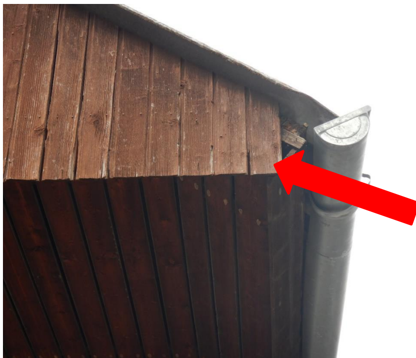
Abb. 4-8: Loch in der Holzverkleidung des Dachüberstandes am auf dem Flurstück 18/7 und 65.
