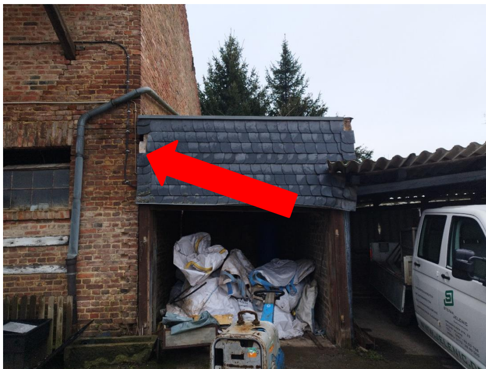
Abb. 4-2: Fehlende Schindeln am Überstand auf dem Gelände des GaLaBau-Betriebs. Hier können Vögel einfliegen und nisten.
