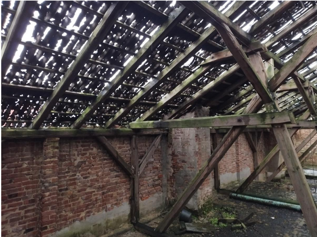
Abb. 4-7: Blick auf die Dachkonstruktion des Stallnebengebäudes. Das Tageslicht scheint auf den Boden. Nahezu alle Wellplatten sind kaputt.
